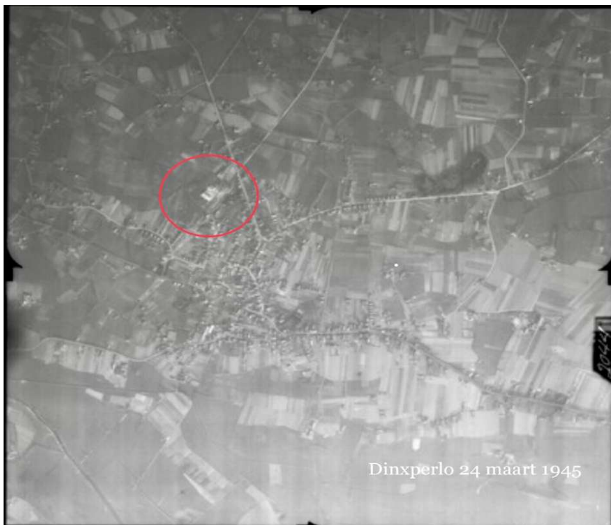
Luchtfoto (NCAP archief) opgenomen op 24 maart 1945 Timmerfabriek van Bussink te Brinke, na het bombardement.
